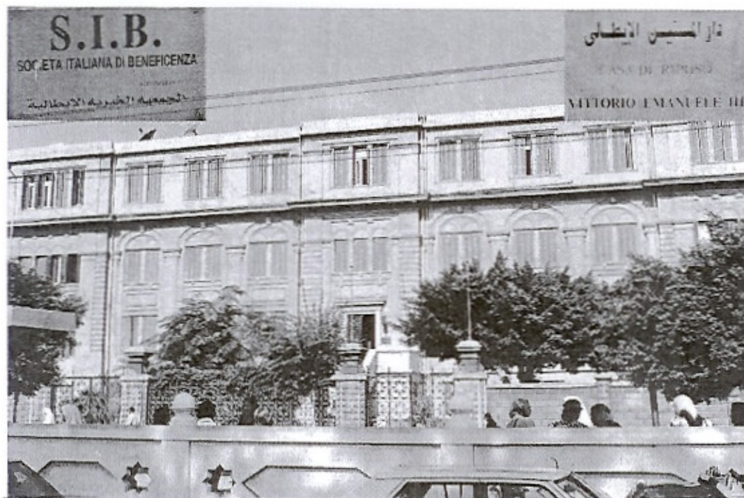
Casa di riposo Vittorio Emanuele III (foto prese in ottobre 2000)
